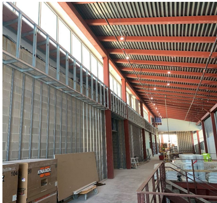
Estructura interior de metal en la columna central del edificio.
