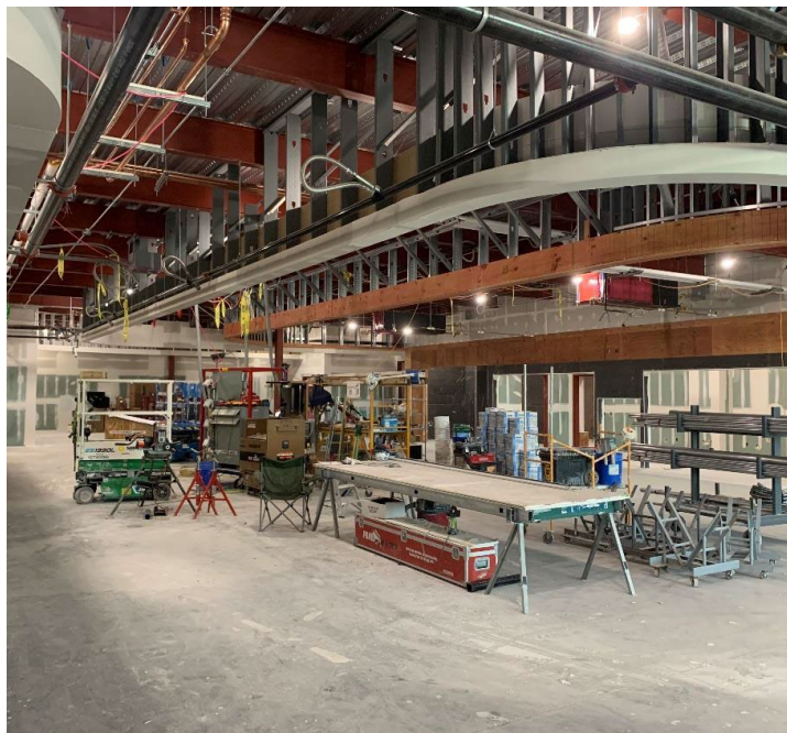
Se están realizando trabajos de encintado y enlucido de los paneles de yeso en la cafetería del primer piso.
